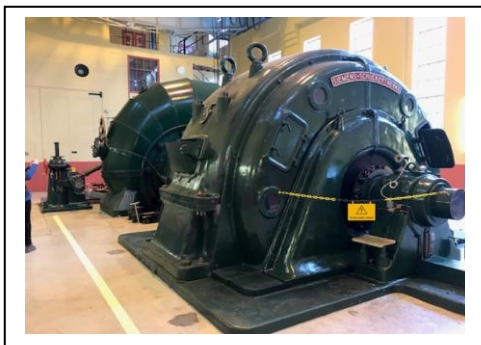
Bilder av Løkaunet kraftstasjon, turbin inne i stasjonen og Springfossen ned mot hengbrua.
